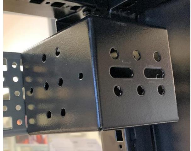
Na distančnike namestite vodila za 19" enote. Za pritrditev uporabite vijake in matice na sliki. Matice držite z uporabo ključa 11.
